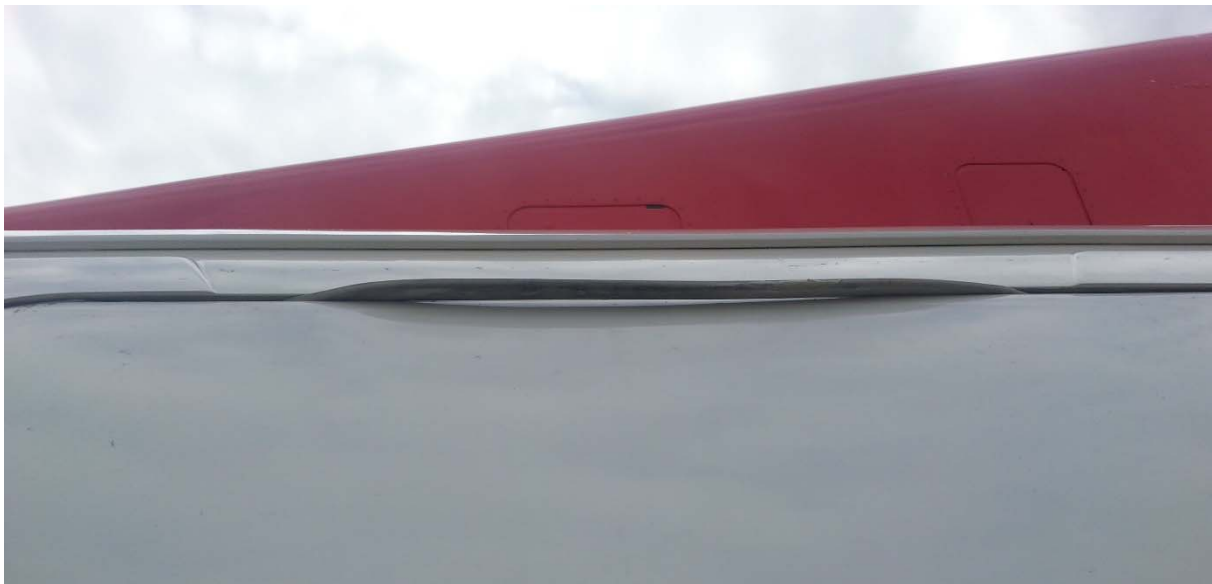
Figure 1 : partie du joint de la porte cargo sorti de son logement
